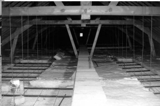
Isolation thermique des combles du bâtiment "Marchette" (chantier en cours)
